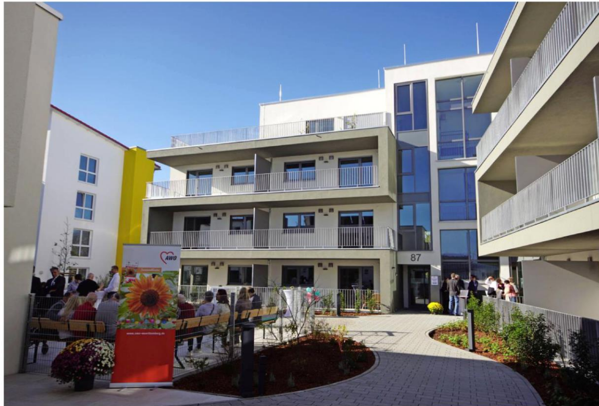
Zur Eröffnung des Integrativen Seniorenwohnens Mannlehenfeld sind viele der Wohnungen noch frei. Marcel Faißt, Geschäftsführer Awo-Württemberg ist überzeugt, dass die barrierefreien Räumlichkeiten binnen vier Monaten vermietet sind. Fotos: Klein
