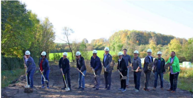
Spatenstich mit Gästen aus Südafrika: Rathausmitarbeiter, Planer und Bauarbeiter starteten am Montag symbolisch den Bau der neuen Abwasserheizzentrale.
